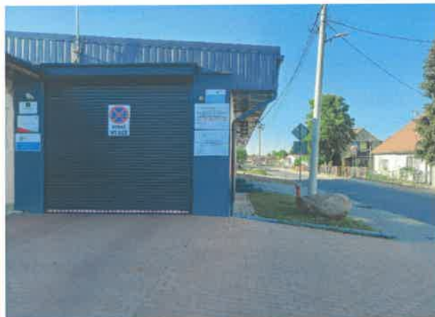
Podjazd do garażu OSP w Wapnicy
